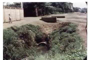
板橋区大谷口付近
